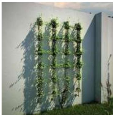
L'effet thermique est d'autant plus ressenti à l'intérieur que l'isolation est faible. Les expérimentations et simulations tendent à montrer que les murs végétalisés sont généralement efficaces sous fortes chaleurs dans le cas de bâtiments non isolés et climatisés (réduction de la consommation énergétique comprise entre 20 % et 30 %).
